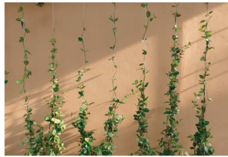
dettaglio tiranti in acciaio e rampicanti
